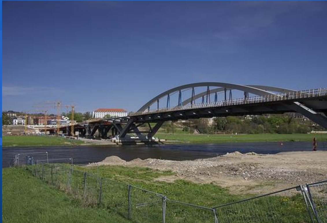
Baustelle der Waldschlösschenbrücke Elbtal Dresden, Deutschland
