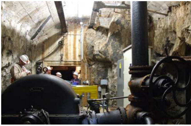
● Vom Wasserrad zur Energiewende: Die Oberharzer Wasserwirtschaft ist eines der größten Energiesysteme der vorindustriellen Zeit weltweit. Die im Schacht laufenden Turbinen erzeugen bis heute den Großteil des Stromes für St. Andreasberg – regenerativ, nachhaltig und damit klimaneutral.
